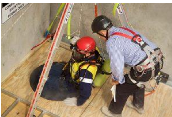
شکل (۴-۶) در برخی موارد استفاده از تجهیزات حفاظت فردی از جمله SCBA جهت ورود به حوضچه ضروری است
