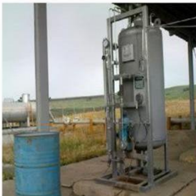
شکل (۶-۱۲) دستگاه بودار کننده
