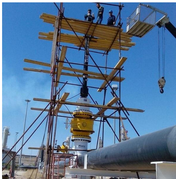
شکل (۶-۹) نمایی از انجام عملیات هات تپ در ارتفاع، دستگاه هات تپ و اتصالات دائم شامل اسپلیت تی و ولو
