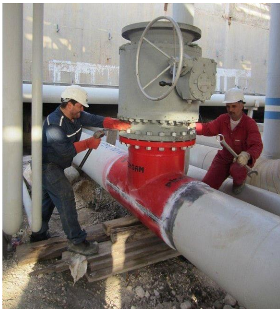
شکل (۶-۶) نمونه ای از شیر نمونه متصل به دستگاه هات تپ
