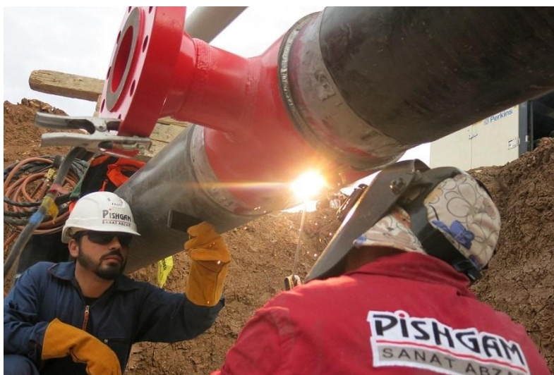
شکل (۶-۱۲) جوشکاری اسپلیت تی روی خط لوله زنده، حاوی سیال
