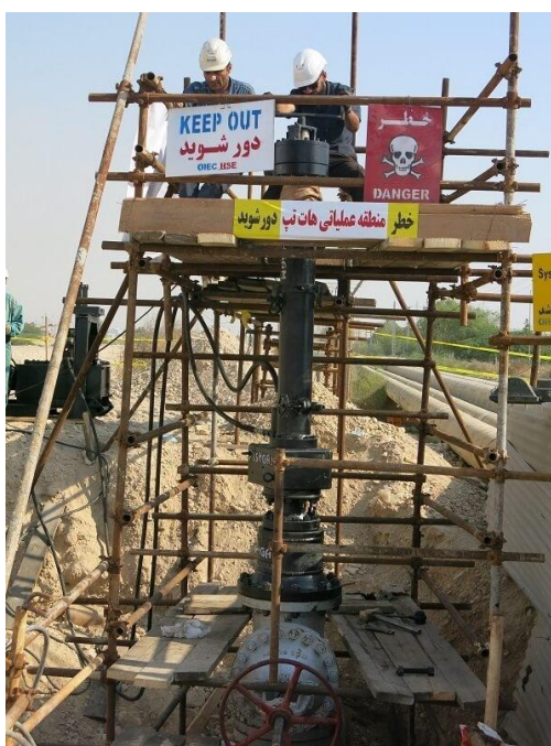
شکل (۶-۱۰) نصب سیستم داربست بندی مناسب برای انجام عملیات هات تپ در ارتفاع
