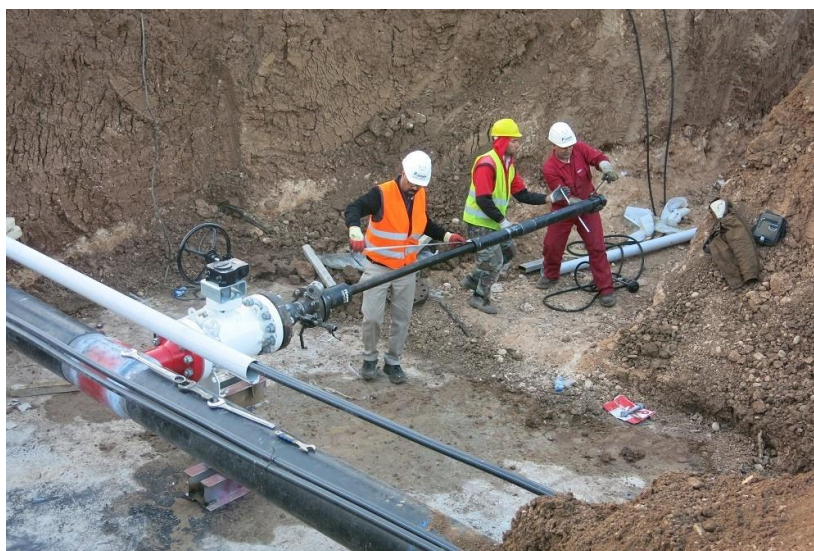
شکل (۶-۱۱) انجام عملیات هات تپ در محل حفاری شده
