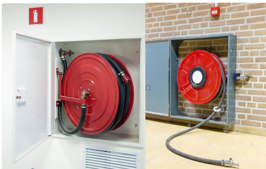
شکل (۵-۶) نمونه هاردهوز جعبه آتش‌نشانی ساختمان‌ها
