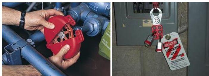
شکل (۴-۶) شیوه صحیح Lock out و برچسب گذاری
