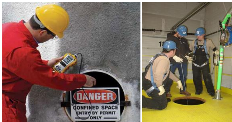
شکل (۶-۲۲) بررسی هوای درون فضای محدود
