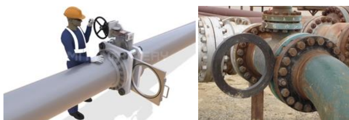
شکل (۵-۶) انجام Blanking and Blinding جهت آماده سازی فضای محدود برای ورود نفرات
