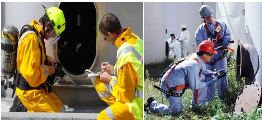
شکل (۶-۳۲) بررسی فضای محدود و ثبت اطلاعات در پرمیت پیش از ورود
