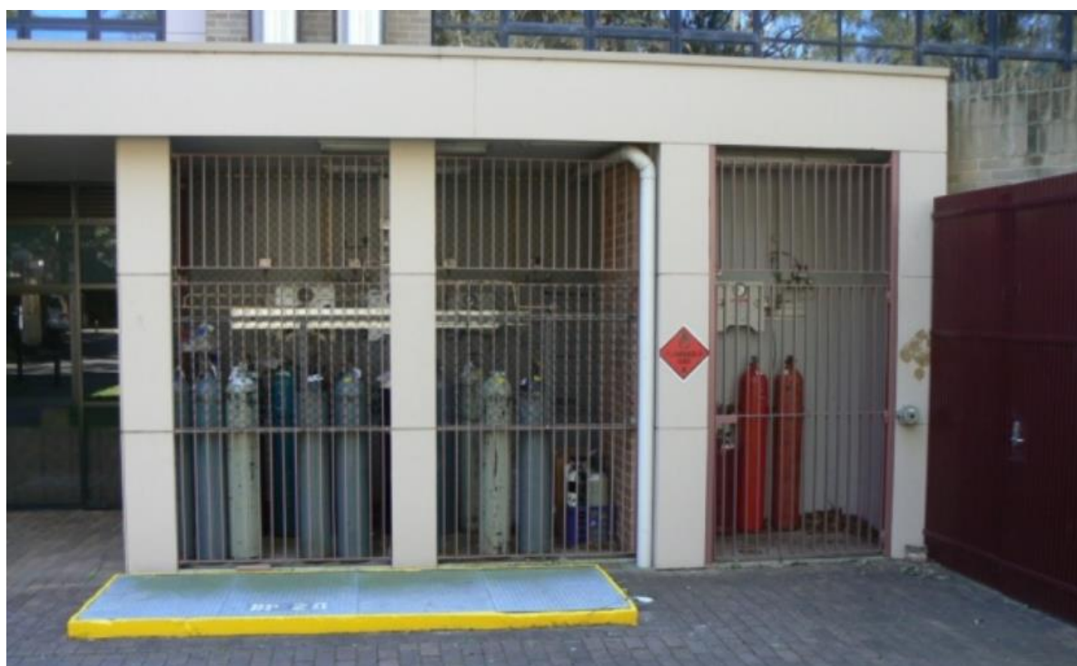
شکل (۶-۱۹) نحوه صحیح چیدمان سیلندره‌ای گاز مختلف در محوطه بیرونی
