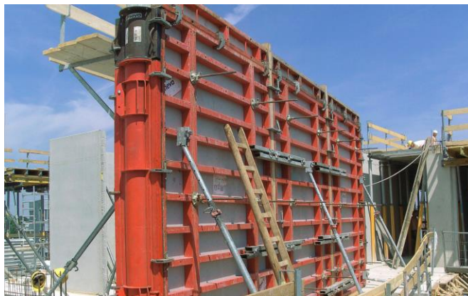
شکل (۳-۵) قالب‌های قائم
