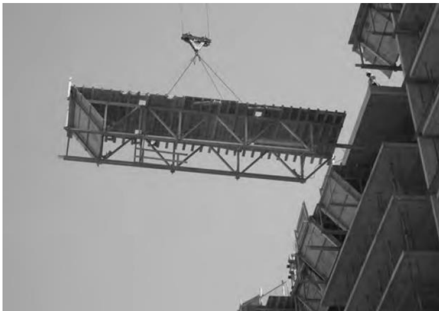
شکل (۶-۲۳) قالب‌های پیش‌ساخته قابل حمل
