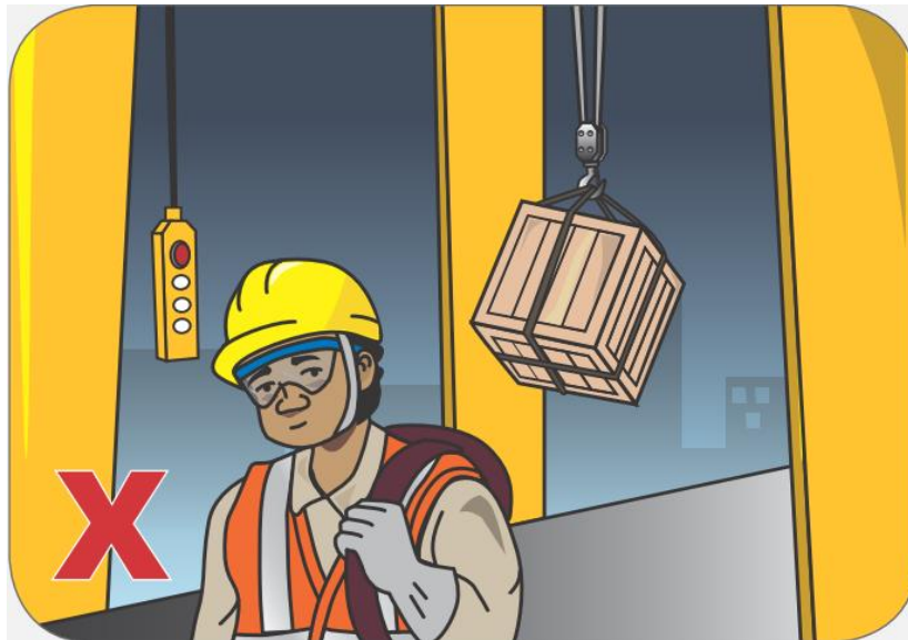
شکل (۶-۲۹) عدم معلق گذاشتن بار بر روی جرثقیل بعد از اتمام کار
