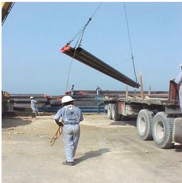
شکل (۶-۳۲) استفاده از Tag Line به هنگام جابجایی بار
