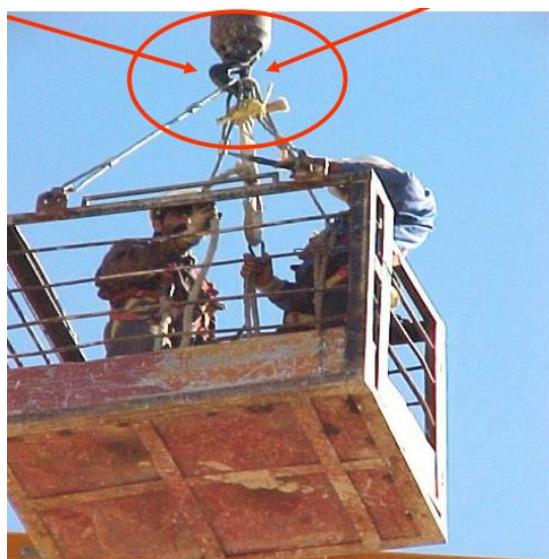
شکل (۶-۴۰) استفاده از قلاب کمر بند ایمنی
