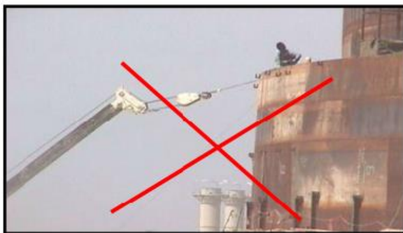
شکل (۶-۲۷) عدم کشیدن بار با جرثقیل
