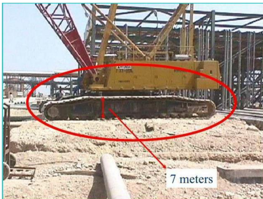
شکل (۶-۱۲) فاصله مجاز جرثقیل تا کانال
