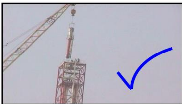
شکل (۶-۲۷) عدم کشیدن بار با جرثقیل
