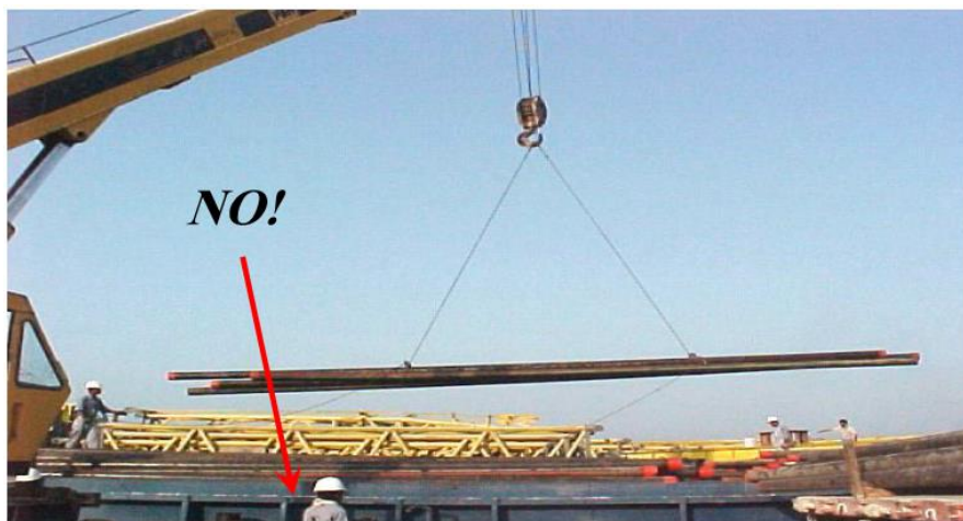
شکل (۳۳-۶) عدم جابجایی بار از روی سر افراد
